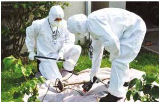
La conductivité électrique autour de la pointe du paratonnerre était censée être plus importante avec la présence d'éléments radioactifs (radium 226 ou américium 241). L'efficacité réelle du système n'ayant jamais été démontrée, la fabrication, la commercialisation et l'installation de ces dispositifs ont été interdites le 1<sup>er</sup> Janvier 1987.
